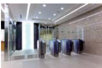
サイトのメインエントランス セキュリティフラップゲート
